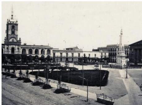
Detalle de 1875 con Torre original del Cabildo
